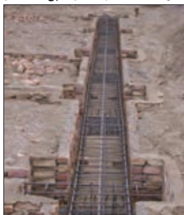
شکل ۳-۱۳۶ پی و شناژ قبل از بتن ریزی
