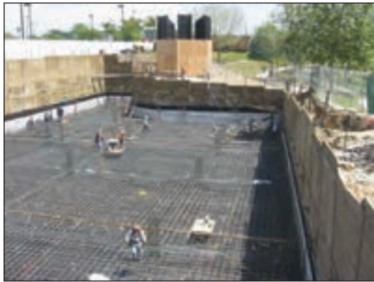
شکل ۳-۶۸ پی بتن مسلح یکپارچه (رادیه ژنرال)
