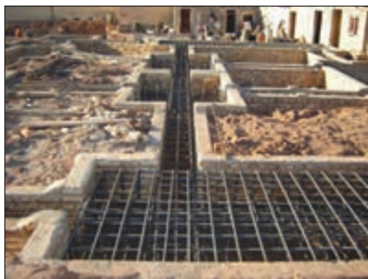
شکل ۳-۱۳۴ میلگردگذاری در پی کلاف بندی
