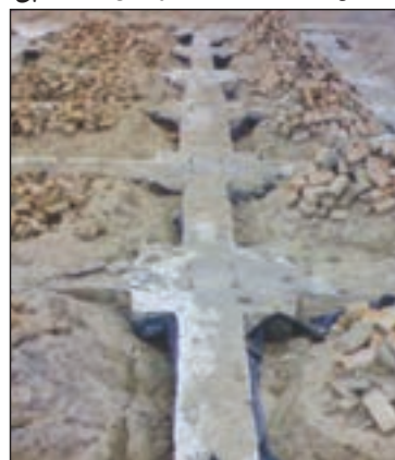
شکل ۳-۱۳۷ پی و شناژ بعد از بتن ریزی
