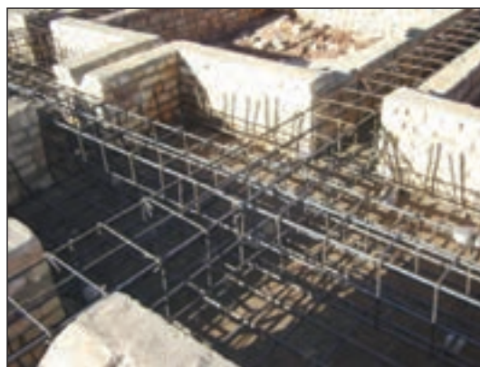
شکل ۳-۱۳۵ عبور میلگردهای شناژ در پی
