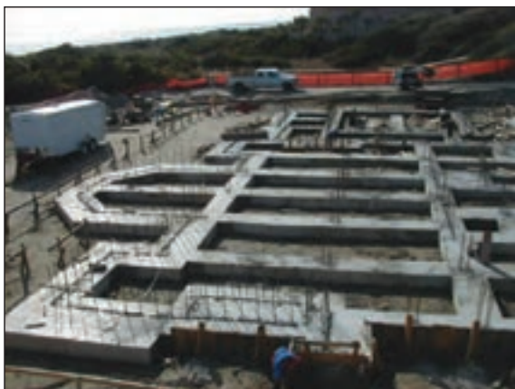
شکل ۳-۶۲ پی بتن مسلح نواری شبکه ای زیرستون
