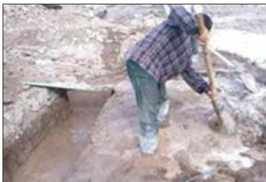
شکل ۳-۳۷ اجرای شفته آهک در فونداسیون
