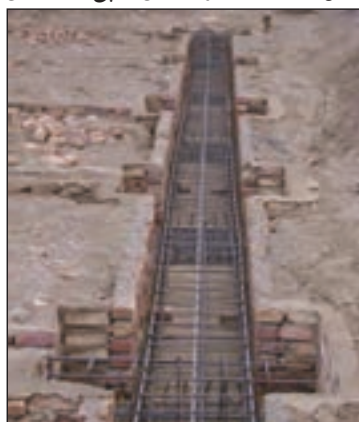
شکل ۳-۱۳۶ پی و شناژ قبل از بتن ریزی
