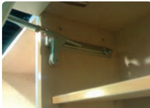
شکل ۶-۳۷ در کابینت نصب شده با نگه‌دارنده پمپی
