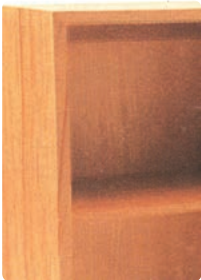
شکل ۶-۷ سقف و کف همرو با بدنه
