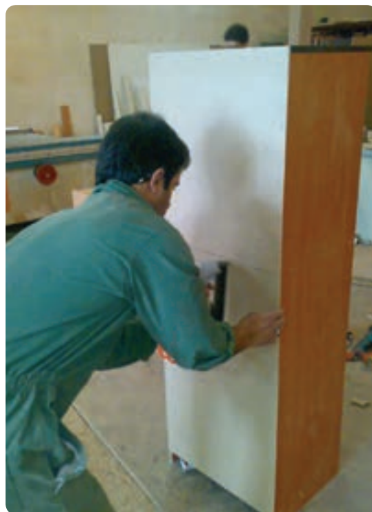
شکل ۱۲۱-۶ نصب پشت بند کابینت
