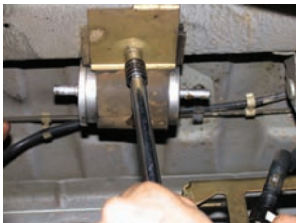
شکل ۱-۴۸ نصب فیلتر جدید
