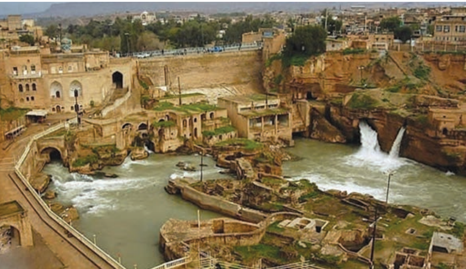
شکل ۵- سازه‌های آبی - تاریخی، شوشتر، خوزستان
