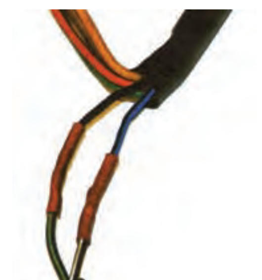
شکل ۶-۶۵- قرار دادن تیوپ عایق روی محل اتصال سیم‌ها
