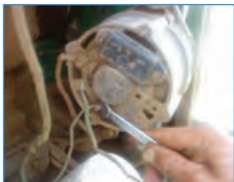
شکل ۳۵-۶ بستن سیم نازک
