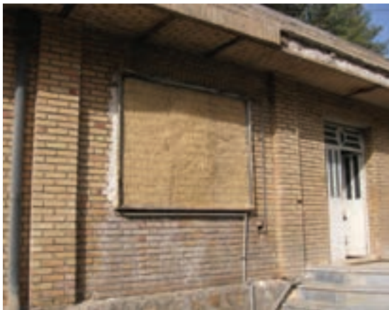
تصویر ۱۳-۲- انواع سیستم پوشال و هواکش
