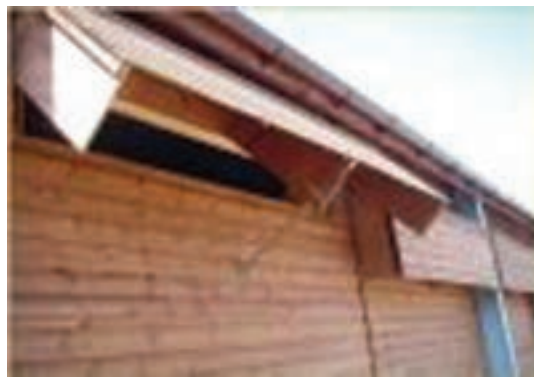
تصویر ۲-۱۴- انواع دریچه‌های ورود هوا
