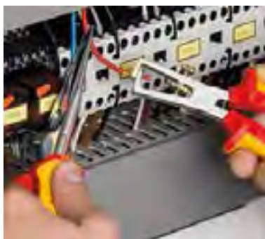
شکل ۱-۹- روکش برداری با سیم لخت کن دستی
