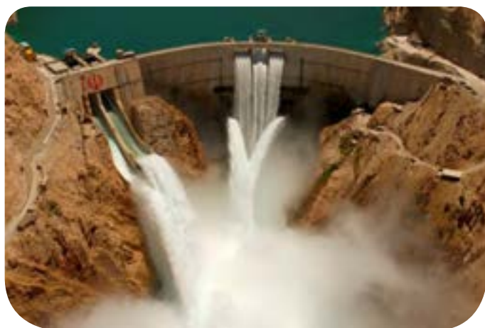
شکل ۲- سد و نیروگاه آبی کارون ۳ استان خوزستان
