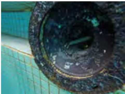
شکل ۴-۵- روشنایی استخر معیوب است و رفع عیب آن باید با رعایت نکات حفاظتی و ایمنی باشد.
