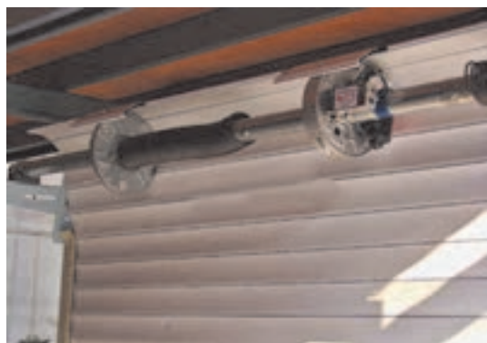
شکل ۱۱- محل نصب موتور کرک‌های
