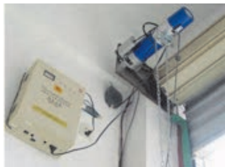
شکل ۱۵- یو پی اس مناسب برای در کرکره ای
