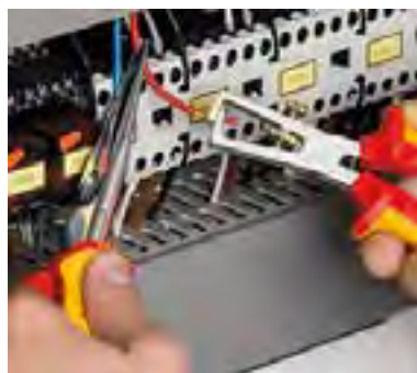
شکل ۱-۹- روکش برداری با سیم لخت کن دستی
