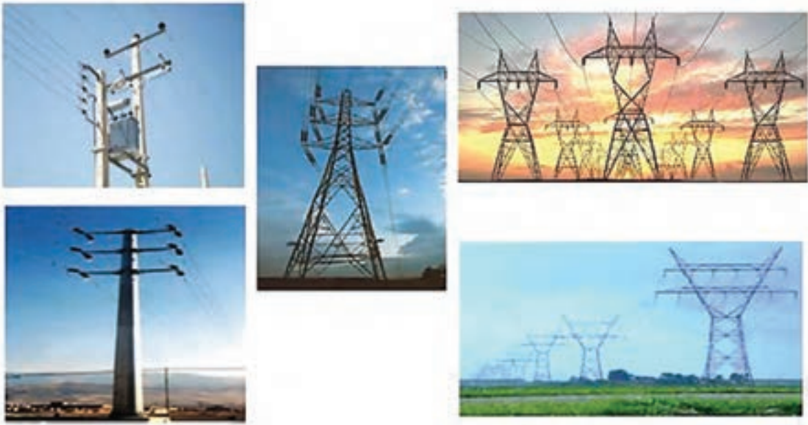
شکل ۱۲- پایه های خطوط انتقال انرژی الکتریکی
