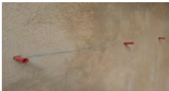
شکل ۳۵- نصب رول پلاک‌ها
