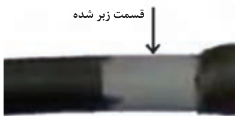
شکل ۷۵- زبر کردن، پاک کردن و تمیز کردن روغن قسمت زبر کابل
