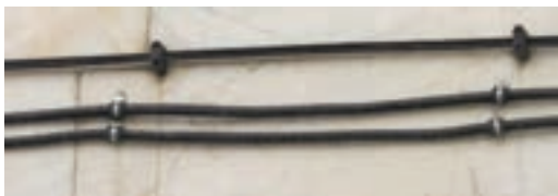
شکل ۲۷ - فاصله بین بست‌ها
