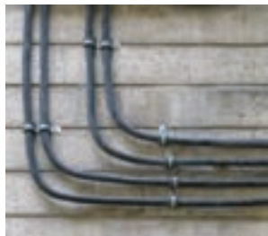
شکل ۲۱- خمش کابل
