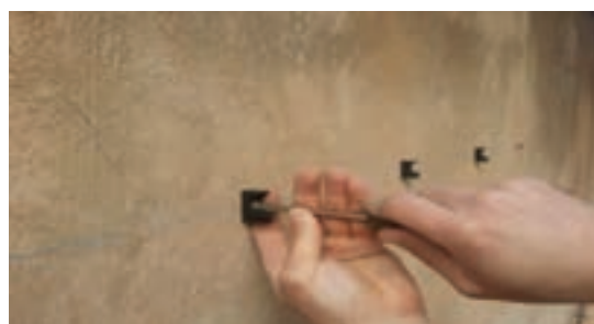
شکل ۳۶- نصب اولیه بست
