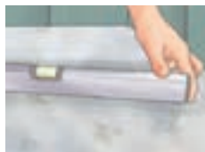
۶- با استفاده از تراز از مسطح و صاف بودن سطح فضا اطمینان حاصل کنید.
