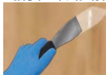
۴- صاف کردن هرگونه ترک از روی دیوار
