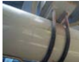
شکل ۱۷-۲ تکیه‌گاه لوله افقی
