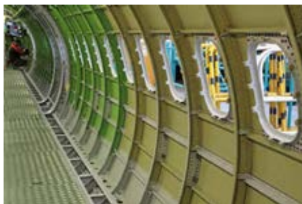
شکل ۱۶-۳ سازه پرچ کاری شده
