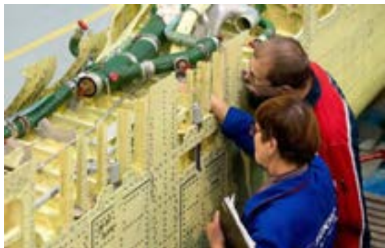
شکل ۱۷-۳ بازدید سازه پرچ کاری شده
