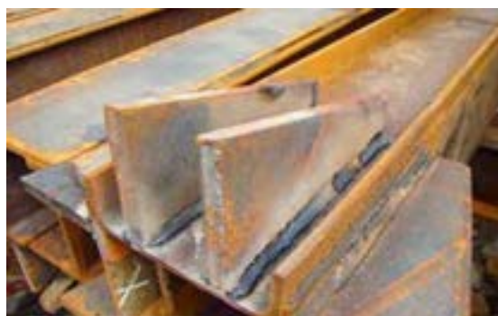
ب) شکل ۳-۱۹ اتصال سازه فلزی جوش کاری
