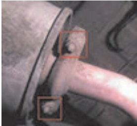
کنترل اتصالات لوله از صدا خفه کن
