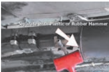
کنترل اجزای داخلی کاتالیست به کمک چکش لاستیکی
