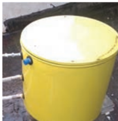
شکل ۳- مخزن انبساط باز با عایق
