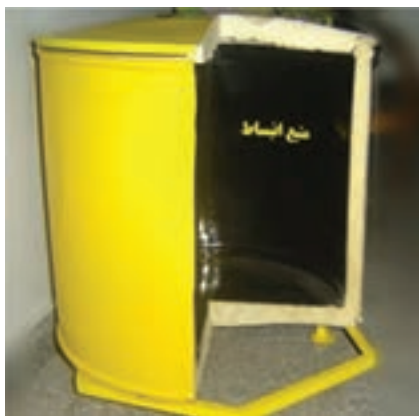
شکل ۳- مخزن انبساط باز با عایق
