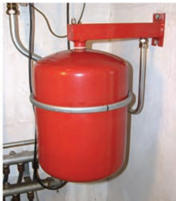
شکل ۱۶- استقرار مخزن انبساط بسته
