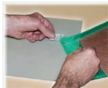
شکل ۳-۱۱- جدا کردن روکش لمینت
