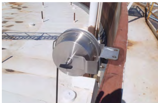
شکل ۴-۲۴ تخلیه الکتریسیته ساکن در مخزن سقف شناور
