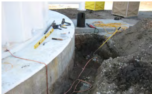
شکل ۴-۲۳ تخلیه الکتریسیته ساکن بدنه مخزن به زمین
