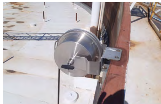
شکل ۴-۲۴ تخلیه الکتریسیته ساکن در مخزن سقف شناور
