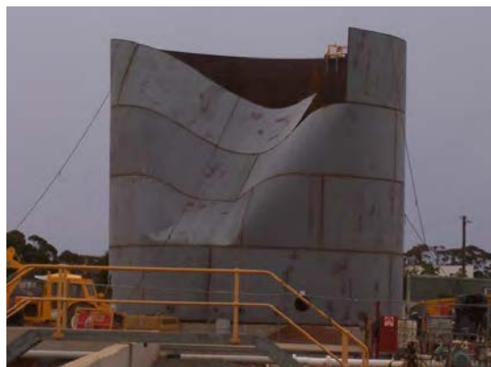
شکل ۴-۲۵ آسیب دیدن مخزن به دلیل وزش باد
