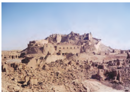
ج) ارگ بم بعد از زلزله
