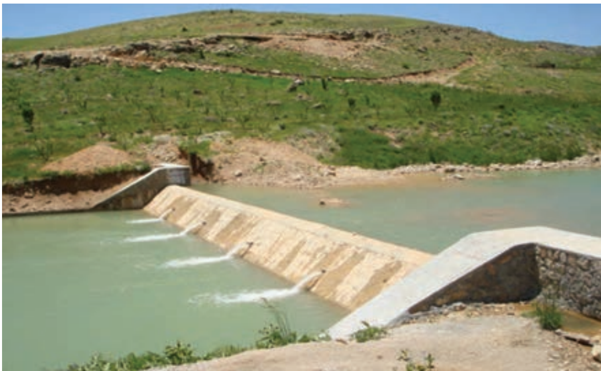
شکل ۲۶-۱- پروژه آبخیزداری بندسنگی ملاتی سرچنار
