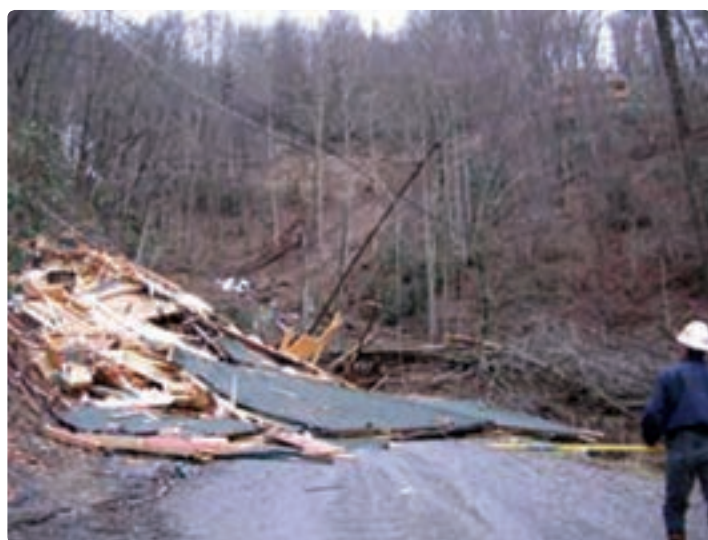
شکل ۱۲-۱- تخریب ناشی از رانس زمین
