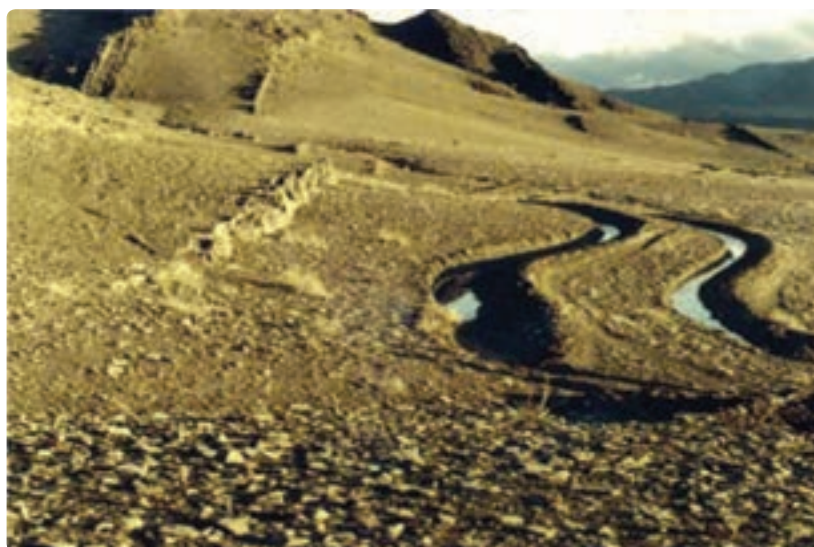
شکل ۳۲-۱- احداث بانکت جهت حفاظت خاک (منطقه فسا)
