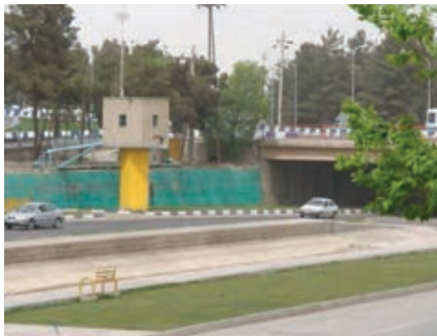
شکل ۱۸-۱- تصویر یکی از چاه‌های آب داخل رودخانه
