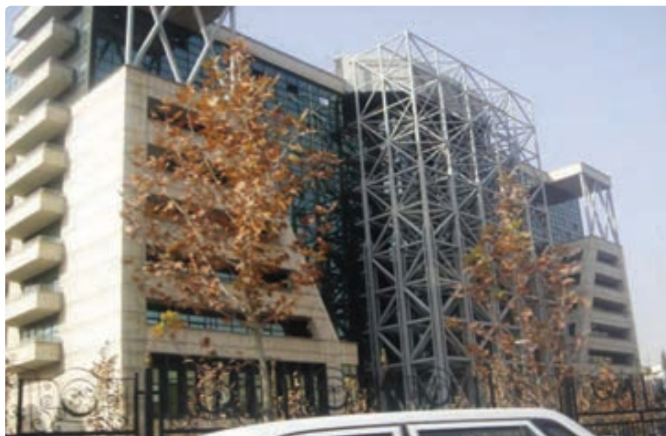
شکل ۱۲-۲- ساخت و سازهای جدید شهری
