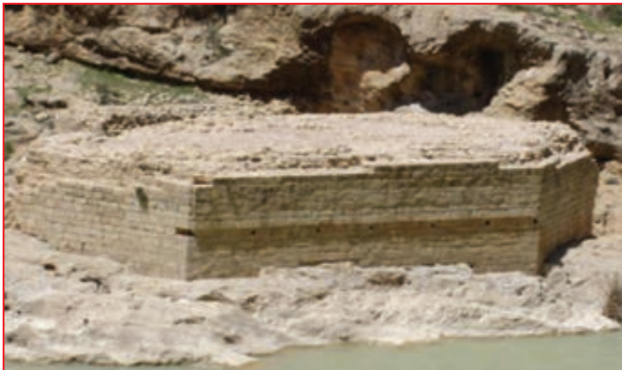
شکل ۳-۴- پایه پل تخت شاه نشین
