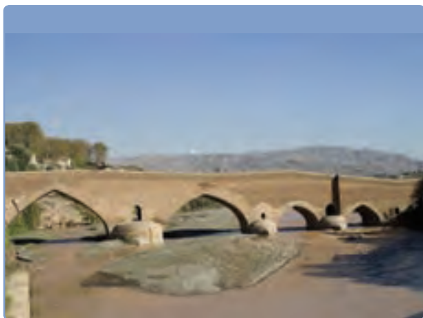
شکل ۱۲-۵- پل تاریخی لوشان (تنها پل ارتباطی به قسمت‌های داخلی کشور)
