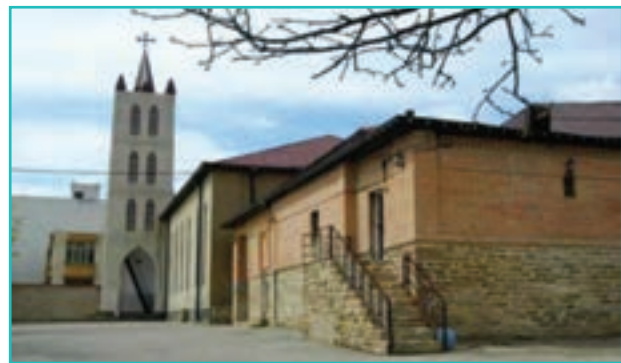
شکل ۳۹- کلیسای ننه مریم - ارومیه
