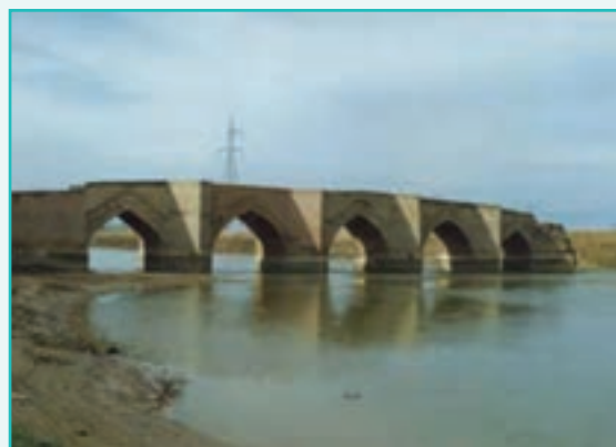
شکل ۲۶-۵- پل میرزا رسول در میاندوآب
