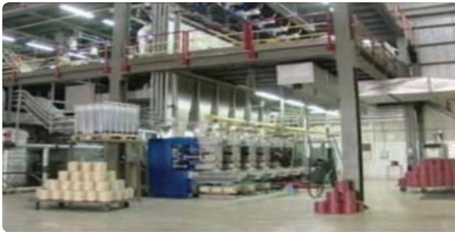
شکل ۱۵-۶- کارخانه کابل نوری یزد
