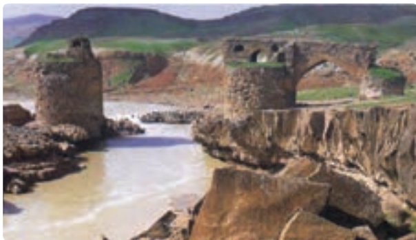
شکل ۲۹-۵- پل گاومیشان دره شهر
