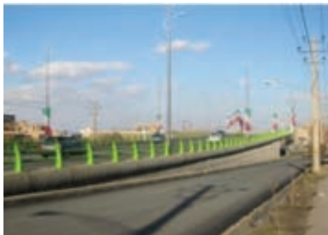
شکل ۱۰-۶- پل روگذر رسالت - همدان
