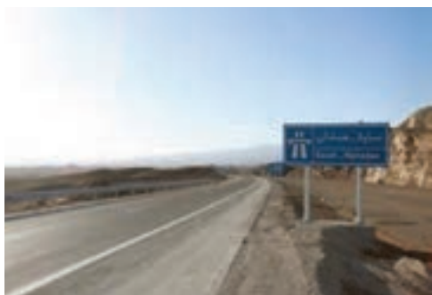
شکل ۱۴-۶- بزرگراه همدان - ساوه
