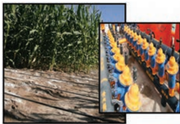
شکل ۱۲-۶- سیستم آبیاری تحت فشار
