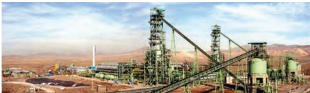
شکل ۳-۶- نمای از کارخانه فولاد خراسان - نیشابور
