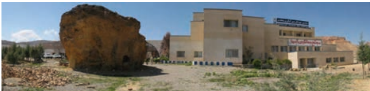
شکل ۵-۵- مجتمع آبگرم محلات
