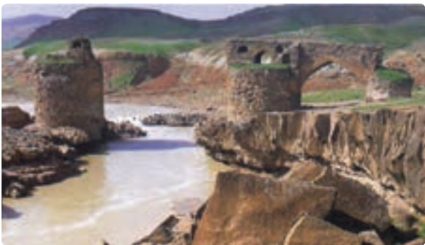
شکل ۲۹-۵- پل گاومیشان دره شهر
