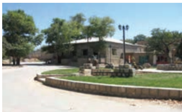
شکل ۲۳-۲- اجرای طرح هادی روستای بدرانلو بجنورد
