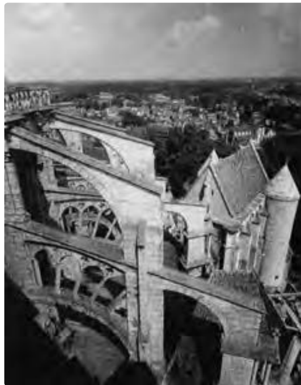
تصویر ۳۴- حایل‌های توخالی دیوارها در معماری گوتیک
