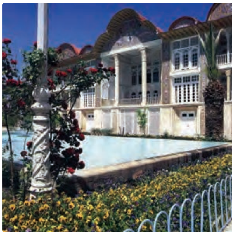
تصویر ۴۲- یک ساختمان برونگرای قاجاری
