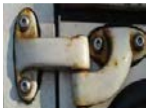
قطعات فلزی عایق شده با پولک پلاستیکی
