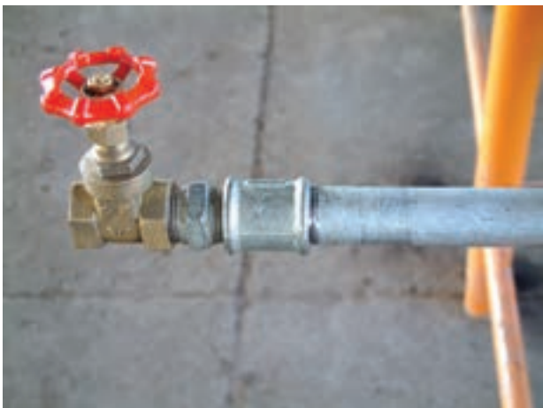
شکل ۴-۸- اتصال دنده‌ای
