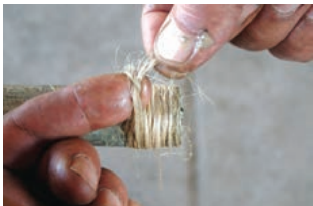
شکل ۵-۵۵- گره زدن انتهای پیچیدن کنف
