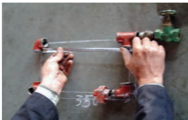
شکل ۵-۱۱۲- اندازه‌گیری طول لوله
