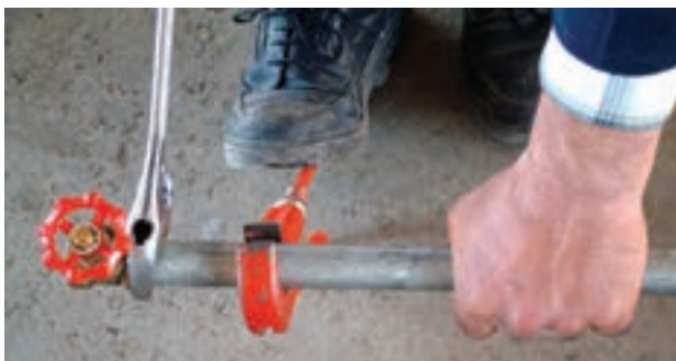
شکل ۱۲۷-۵ نحوه‌ی باز کردن شیرفلکه از لوله به وسیله‌ی یک آچار
