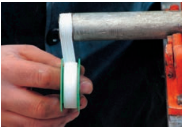
شکل ۵-۵۸- نحوه پیچیدن نوار تفلون بر روی سردنده
