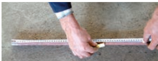
شکل ۳-۵۴ خط کشی لوله و تعیین محل‌های خم
