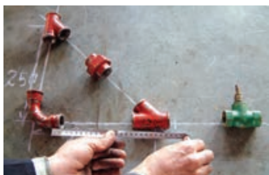
شکل ۱۳۴-۵ اندازه‌گیری لوله‌های مورد نیاز
