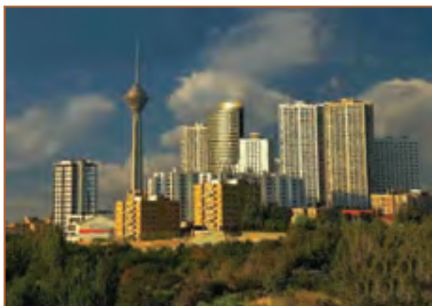
الف - ساختمان سازی
