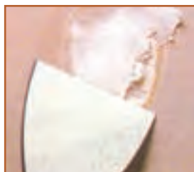
ب - لکه گیری و ترمیم ترک‌ها
