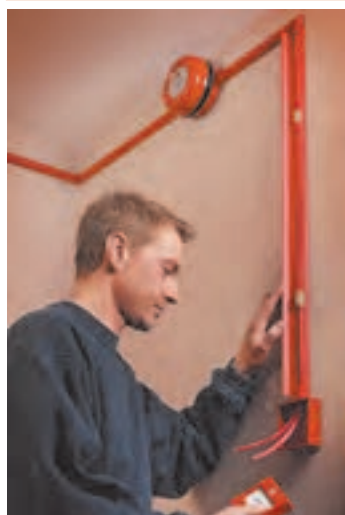
شکل ۱۹- گلند مقاوم در برابر حریق
