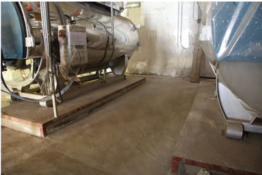
شکل ۱۴ - نصب دیگ روی فونداسیون
