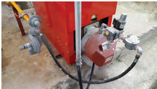
شکل ۲۹- اتصال مدار سوخت
