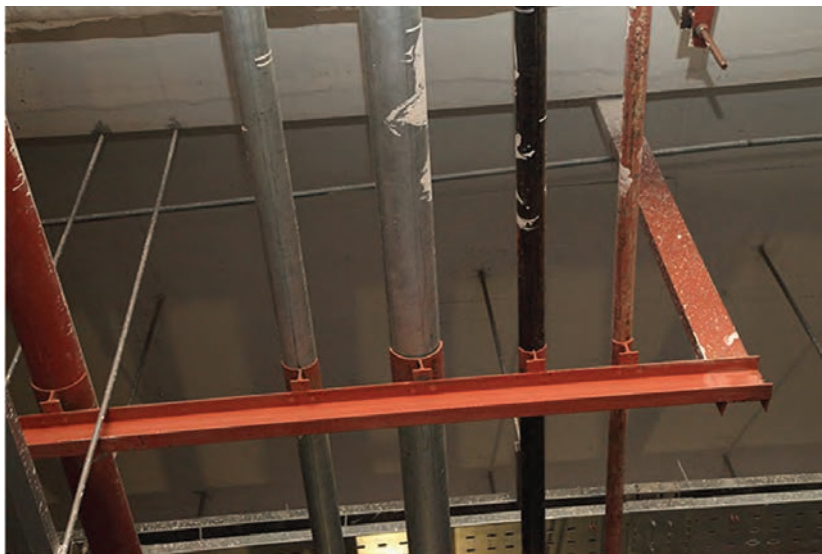
شکل ۱۶- آویز چند لوله‌ای
