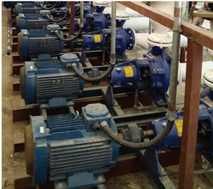
شکل ۲۴- اتصال موتورهای سه فاز
