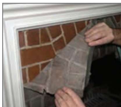
شکل ۲۱- دوده‌زدایی مکانیکی به روش برچسب پاک کننده
