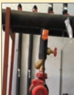
ترموستات جداری نصب روی عایق گرمایی
