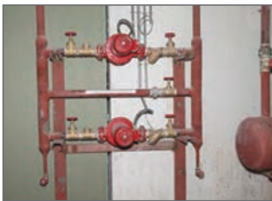
شکل ۱ - پمپ سیرکولاتور سیستم گرمایی
