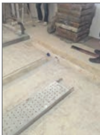
شکل ۳۰- نمونه کانال آب‌روی موتورخانه - گاتر
